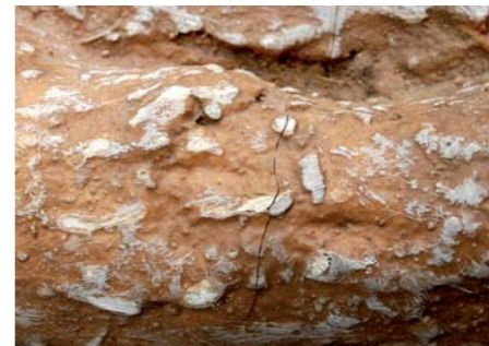
Pitzadura. Fisura.
