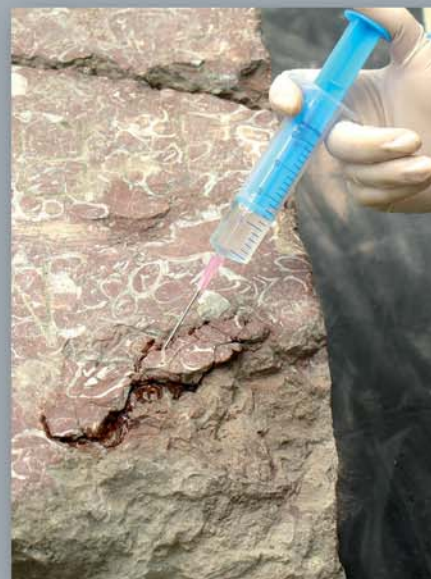
Zatiak finkatzea. Fijación de fragmentos.
