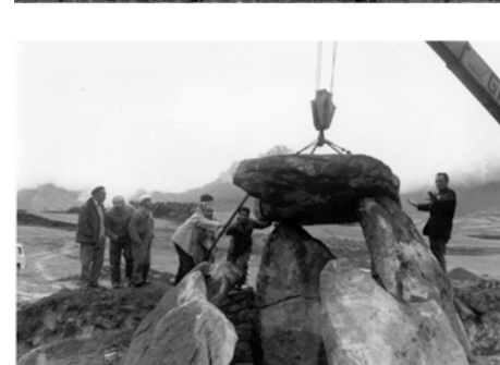
1974. Dolmen restoration works. Travaux de restauration du dolmen.
