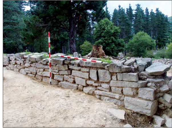
Izda.: Imagen del transcurso de la excavación en C2. Dcha.: Lienzo de muro SW de C2 y calle.
