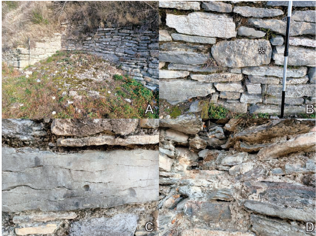
Figura 6. Calizas locales en la muralla. A: mampostería descansando directamente sobre el sustrato de calizas. B: arriba en blanco, plano de diaclasa con cristalización de calcita. (*) Superficie karstificada o cara de talud. C: Cara de talud con moldes de erizos. D: ripios dentro de una tongada de cal hidráulica con cantos rodados.
