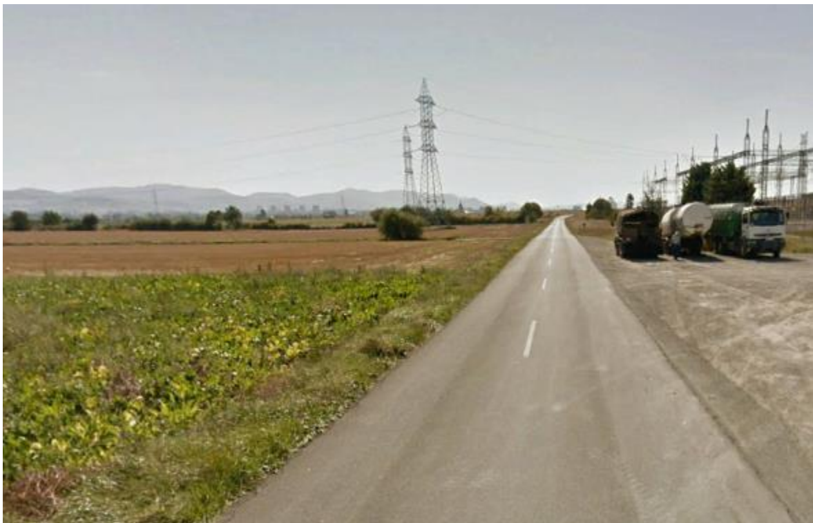
Fotografía nº 22. Vista carretera A-3008, a la izquierda parcela nº 237 del polígono 36, que pertenece al ámbito del plan especial, a la derecha subestación Vitoria de REE.
