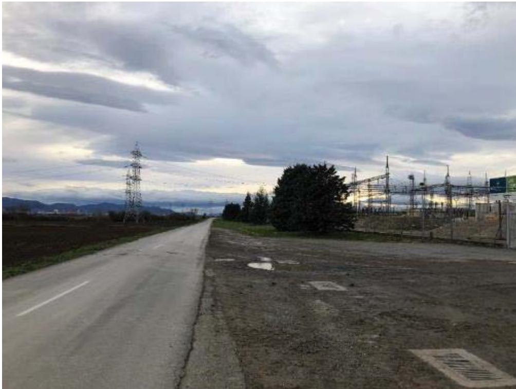
Fotografía nº 16 Vista desde la carretera A-3008 de la subestación eléctrica Vitoria.
