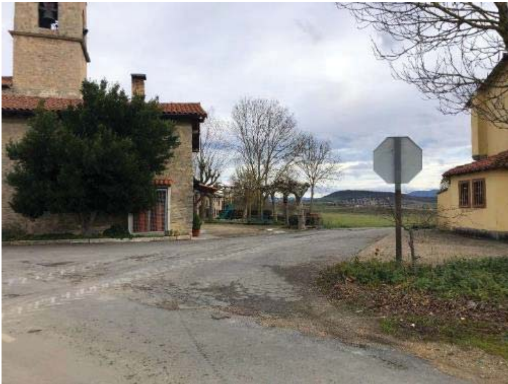
Fotografía nº 6 Vista carretera que atraviesa Lubiano.
