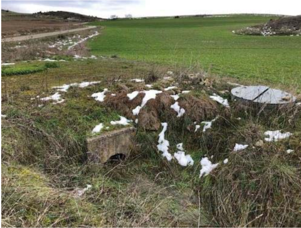
Fotografía nº 24 Vista acceso a la parcela 439 del polígono 1, y arqueta de con válvulas de regadío.
