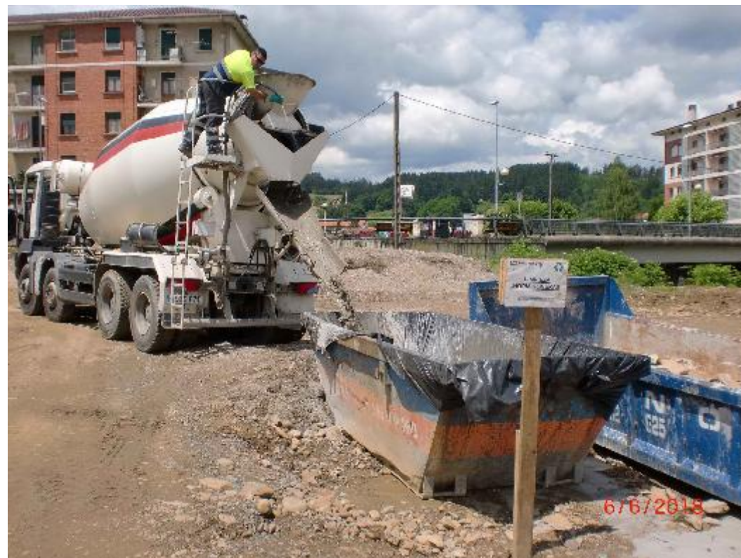
limpieza de hormigonera
