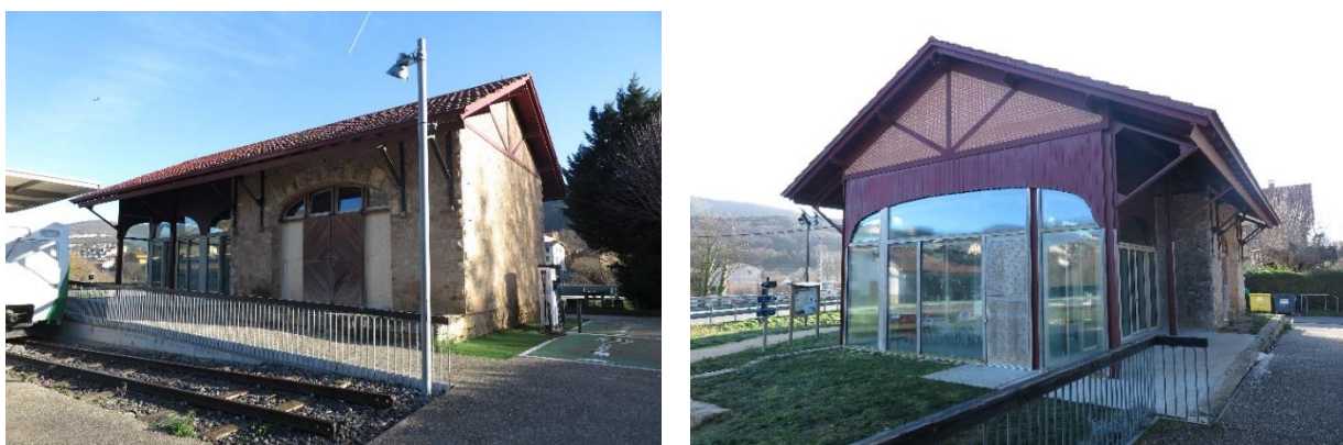
Fig.07: Ampliación y Rehabilitación del edificio muelle en Antoñana como bar, con Protección de Nivel 3.
