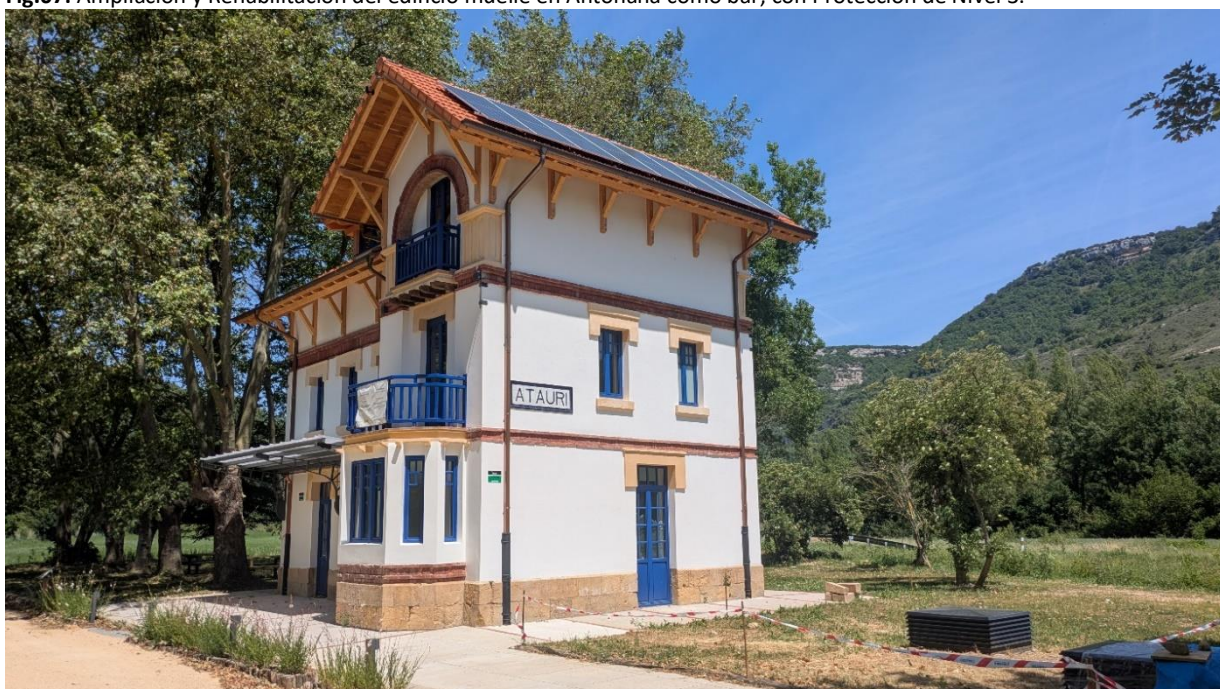
Fig.08: La estación de Atauri recién terminada la obra de restauración (junio, 2026).
